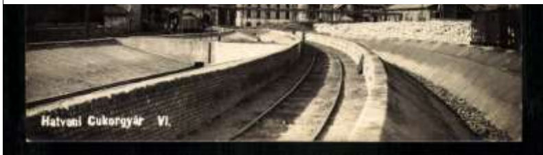
8. A képsalagon jól látszik a vágányok mellett húzódó répaúszató beton csatornája is
